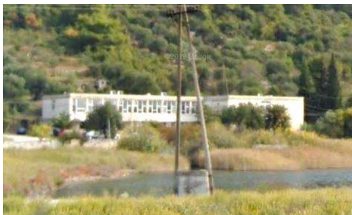
2. zgrada MŠ Ston
